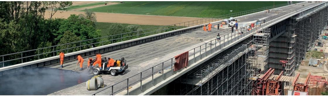
**Der Werkstoff Gussasphalt gewinnt immer mehr an Bedeutung und bildet die Grundlage für eine dauerhafte Abdichtung im Hoch- und Tiefbau.** Gussasphalt ist ein thermoplastisches, wasserdichtes, frost-tau-salzbeständiges und wurzelfestes Material. Er besteht aus Füller, Sand, Splitt und Bitumen als Bindemittel. Die Aufbereitung erfolgt in speziellen Mischanlagen. Anschließend wird das Mischgut im viskosen Zustand mit Transportkochern auf die Baustelle transportiert.
